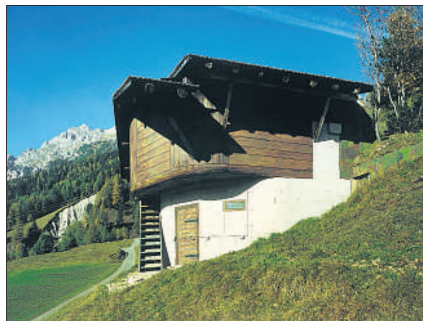
Falsches Chalet: Verkleideter Bunker in Sufers, fotografiert von Christian Schwager.
