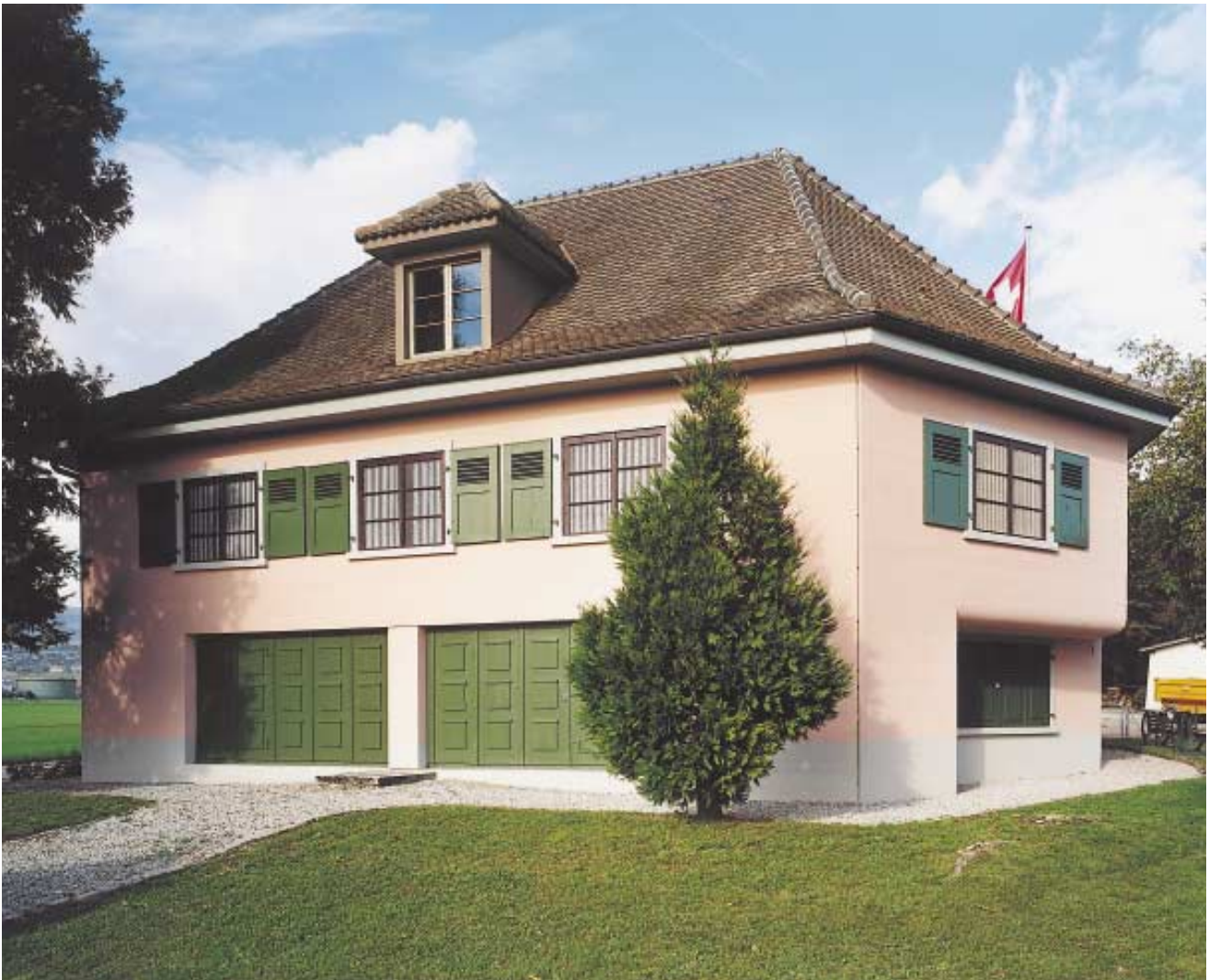
«Falsche Chalets»: Wohnhäuser, Scheunen und Ställe erweisen sich bei näherem Hinschauen als getarnte Bunker.
