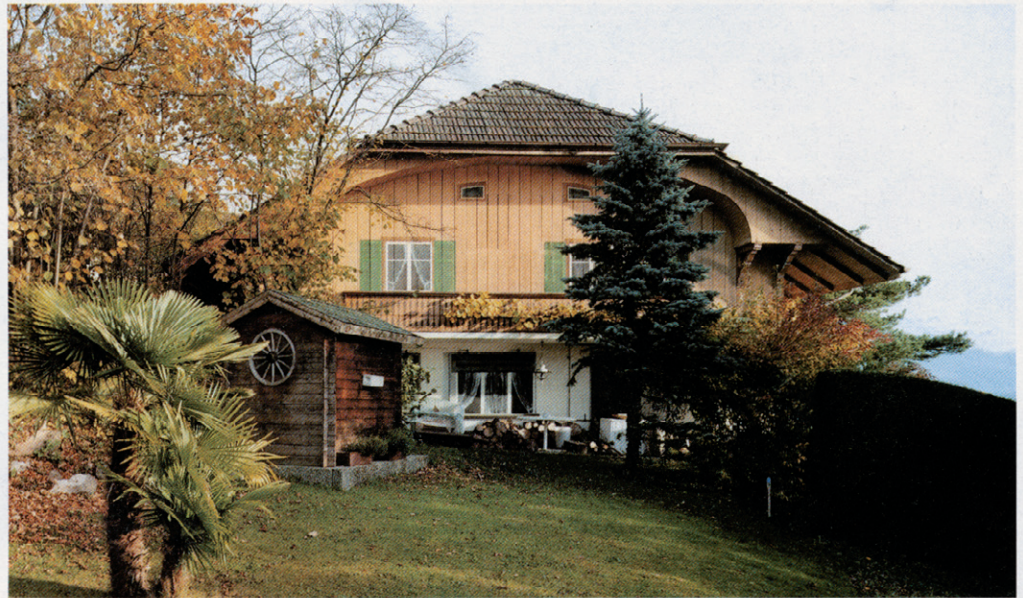
Liebliches Landhaus: ein Infanteriebunker mit aufgemalter Bretterfassade in Hilterfingen BE
