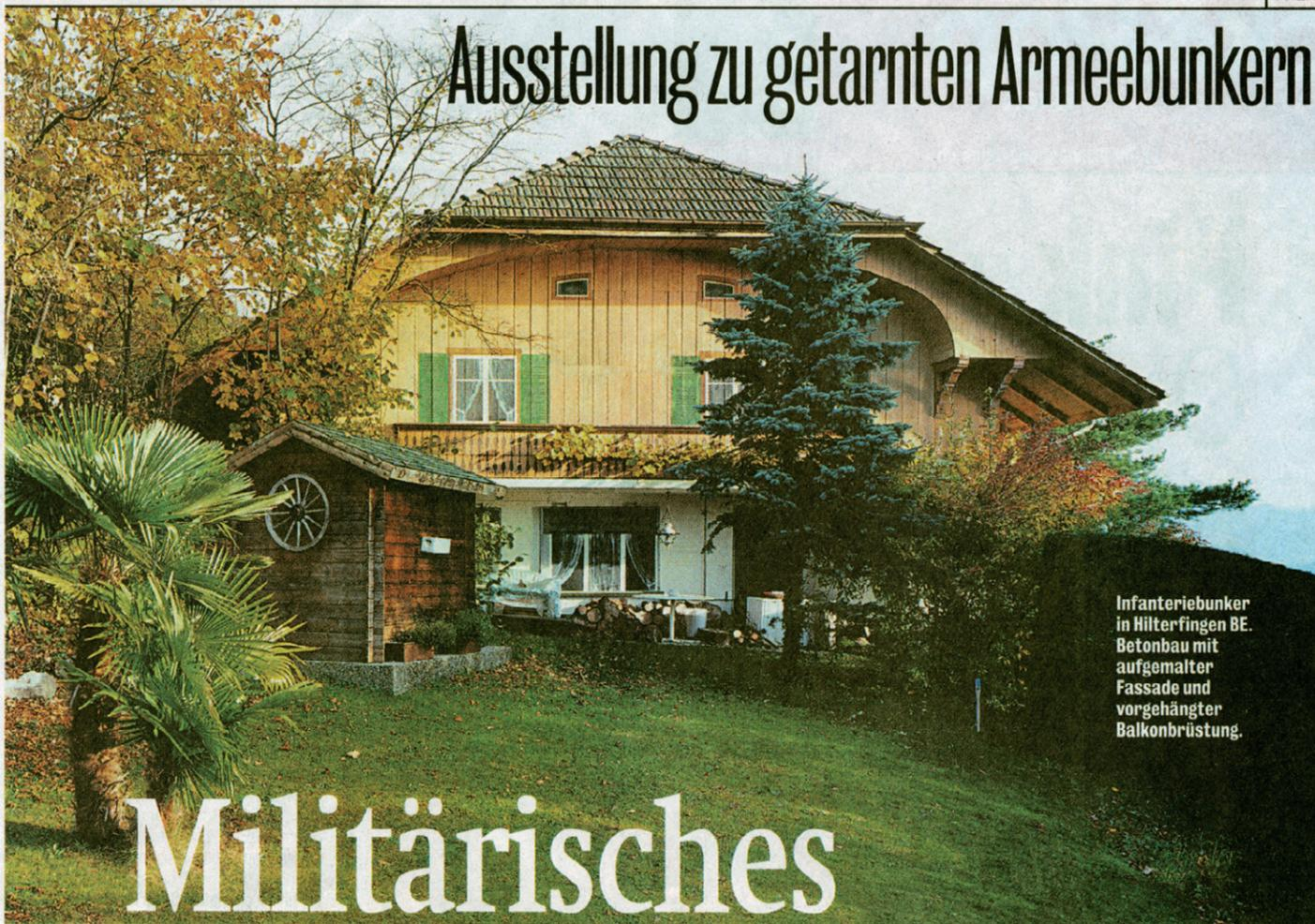
Infanteriebunker in Hilterfingen BE. Betonbau mit aufgemalter Fassade und vorgehängter Balkonbrüstung.
