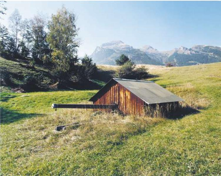
Das ist ein 10,5-Zentimeter-Panzerturm schweizerischer Konstruktion, mit dem man rundherum schiessen kann. Das funktioniert im Grunde ähnlich wie ein Schiffsgeschütz.
